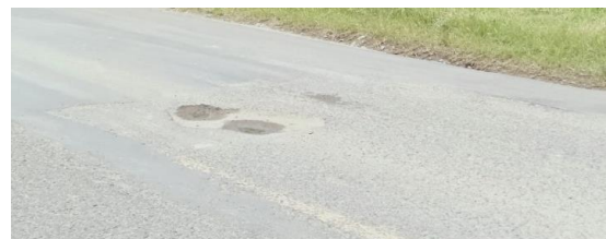
Gambar 2. Kerusakan Lubang
